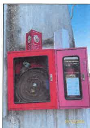
ภาพที่ 73 การติดตั้งถังดับเพลิง สายฉีดน้ำ ดับเพลิง และท่อน้ำดับเพลิง
