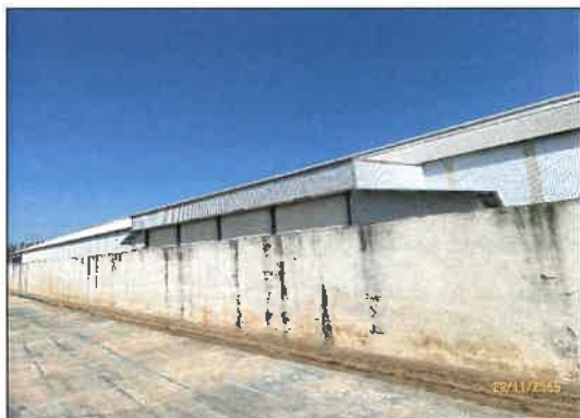
ภาพที่ 20 คันคอนกรีตป้องกันกากน้ำตาลที่อาจ รั่วไหลออกจากถังเก็บกากน้ำตาล
