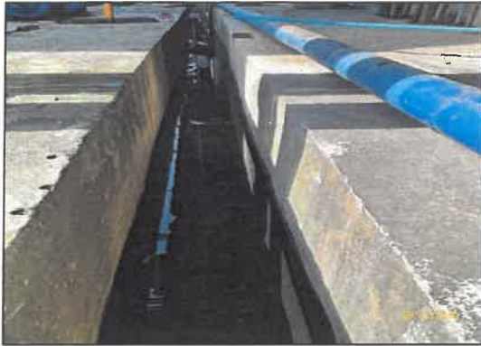
ภาพที่ 15 รางระบายน้ำข้างสารถรองของระบบ ผลิตน้ำใสของโครงการ
