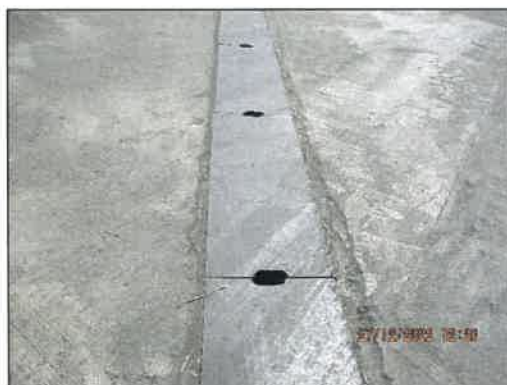
ภาพที่ 14 รางระบายน้ำเสียจากการล้างพื้นและอุปกรณ์เครื่องจักรของโครงการ
