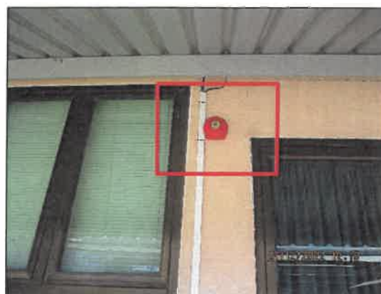
ภาพที่ 72 การติดตั้งสัญญาณแจ้งเหตุเพลิงไหม้
